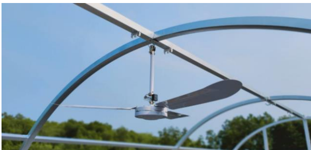
ภาพที่ 10 การติดตั้งพัดลมกับโครงสร้างเหล็กโรงเรือน
