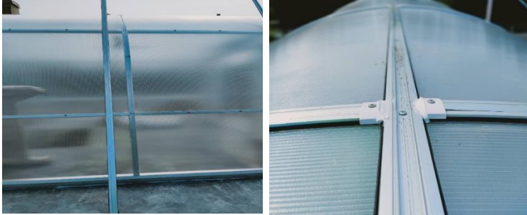
ภาพที่ 11 การติดตัวหนีบบนแผ่นโพลีคาร์บอเนต
