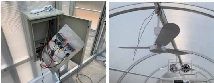
ภาพที่ 12 การติดตั้งตู้ไฟฟ้า เพื่อเชื่อมต่อกับอุปกรณ์ในตู้ไฟฟ้า และอุปกรณ์ อื่น ๆ
