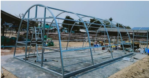
ภาพที่ 9 โครงสร้างเหล็กโรงเรือน
