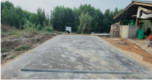
ภาพที่ 8 การเทพื้นปูนโรงเรือนอบแห้ง
