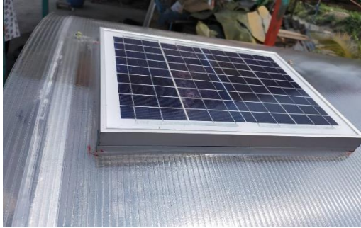
ภาพที่ 10 การติดตั้งแผงโซลาร์เซลล์ ขนาด 10 W
