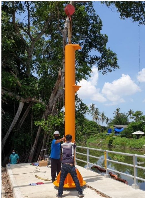
ภาพที่ 33 การติดตั้งเสาครนและแขนยื่น
