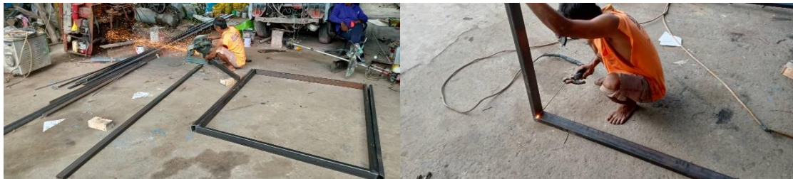
ก. ขั้นตอนการตัดเหล็ก
