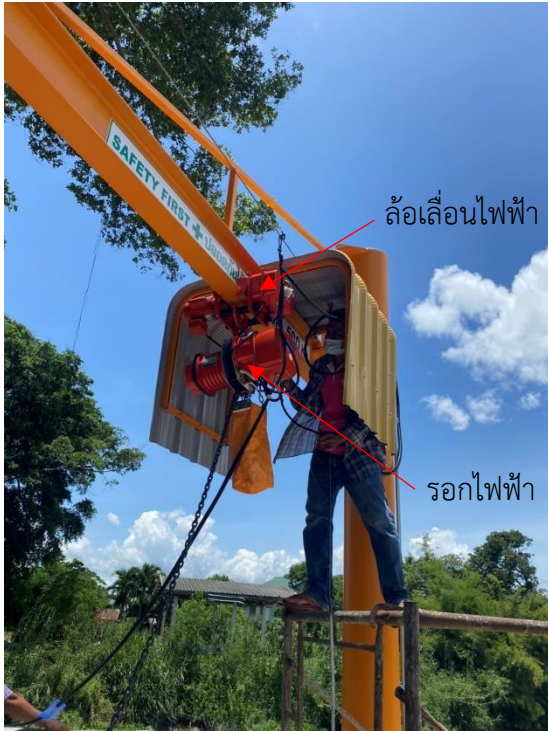
ภาพที่ 34 ประกอบชุดรอก ล้อยื่นและตู้ควบคุมไฟฟ้า
