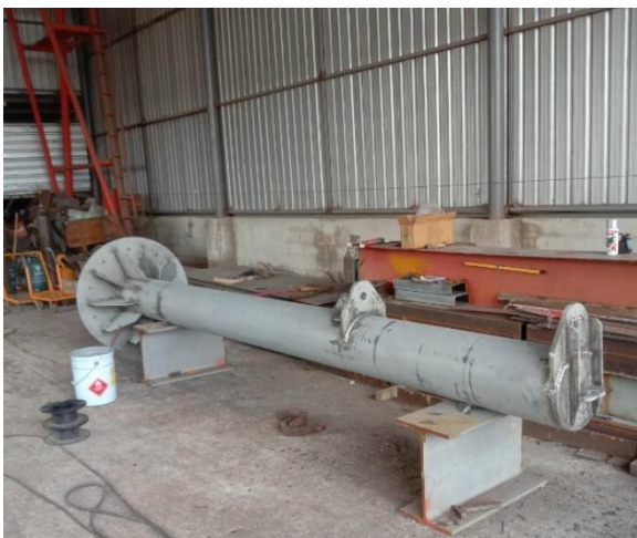
ก. เสาเครนผ่านการเชื่อมและทำสีรองพื้น
