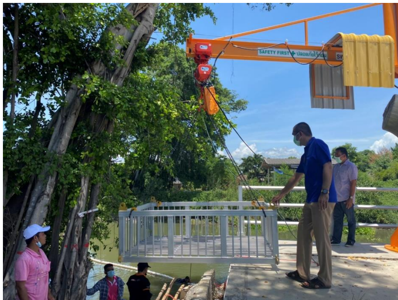
ภาพที่ 35 ประกอบโซ่เข้ากับกระเช้าและรอกไฟฟ้า
